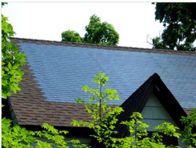
Installare un impianto fotovoltaico azzerava per una ventina d'anni la bolletta energetica
