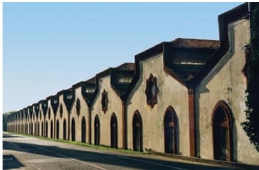
Le case operaie, di ispirazione inglese, sono allineate ordinatamente a est dell'opificio lungo strade parallele
