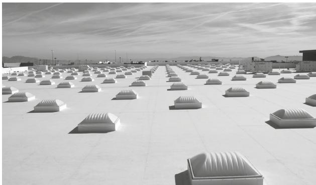
Il tetto bianco e i tunnel solari su un grande magazzino a Las Vegas riducono i consumi energetici e l'effetto "isola di calore" rispetto a un tetto scuro.
